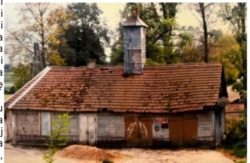
BUDYNEK DREWNIANY REMIZY 14-05-1998 R.
